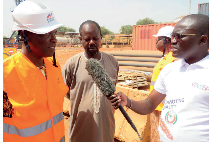
Les ministres en charge de la Qualité visitent un chantier de construction routière Ministers in charge of quality visit a road construction site
