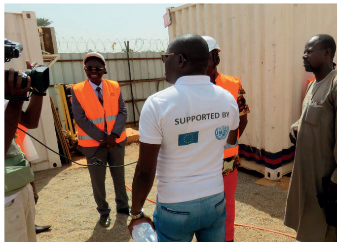
Les ministres en charge de la Qualité visitent un chantier de construction routière Ministers in charge of quality visit a road construction site
